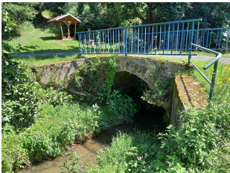
11. Obcí protéká od severu k jihu říčka Rohelnice, do které budou vyústěny vyčištěné odpadní vody.
